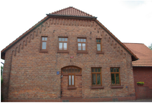
Ziegelfassade mit Gesimsgliederung
