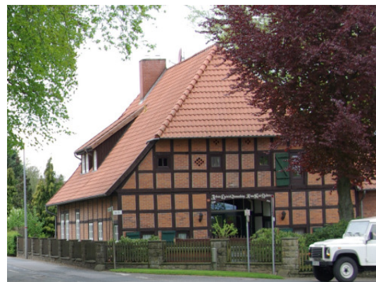
Fachwerk mit Ziegelausfachung (Borstel)
